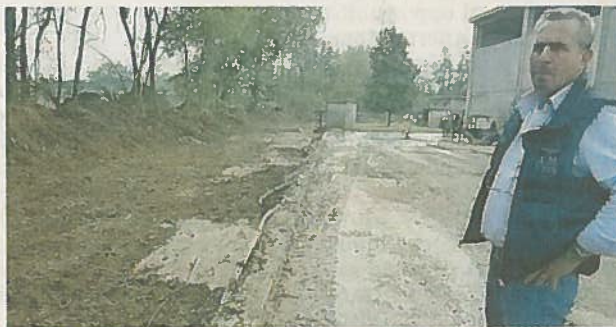
Basaluzzo, danni al Consorzio di depurazione
